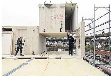
tegrierter Sanitäreinheit. Diese Module kamen vorgefertigt aus dem Werk der Firma Kaufmann in Kalwang. An Ort und Stelle wurden sie dann bloß noch an- bzw. aufeinander gestapelt und entsprechend fixiert. Innen sind die Brettsperrholzwände unverkleidet geblieben und verströmen im Kontrast
