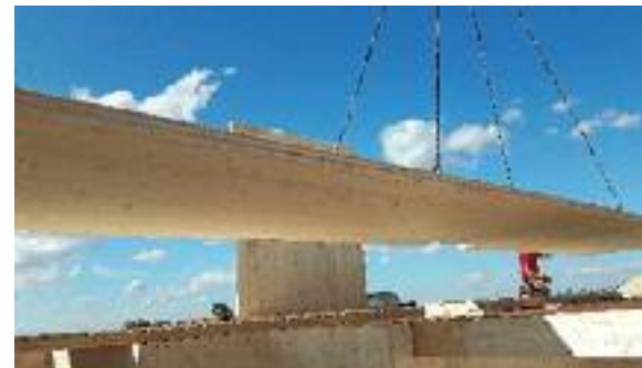
Am Stammsitz der Mayr-Melnhof Holz Holding AG in Leoben entsteht ein neues Brettsperrholzwerk.
