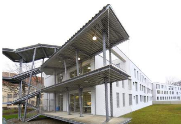
Neubau 'Zentrum für Suchtmedizin' am LKH Graz Süd-West Foto: Pachernegg
