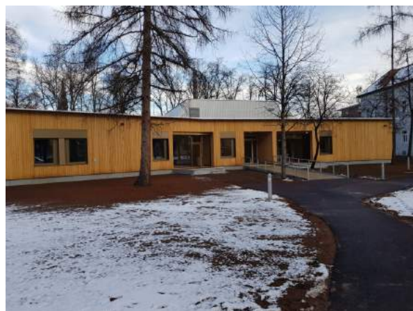
Holzbau der Ausweichstation
