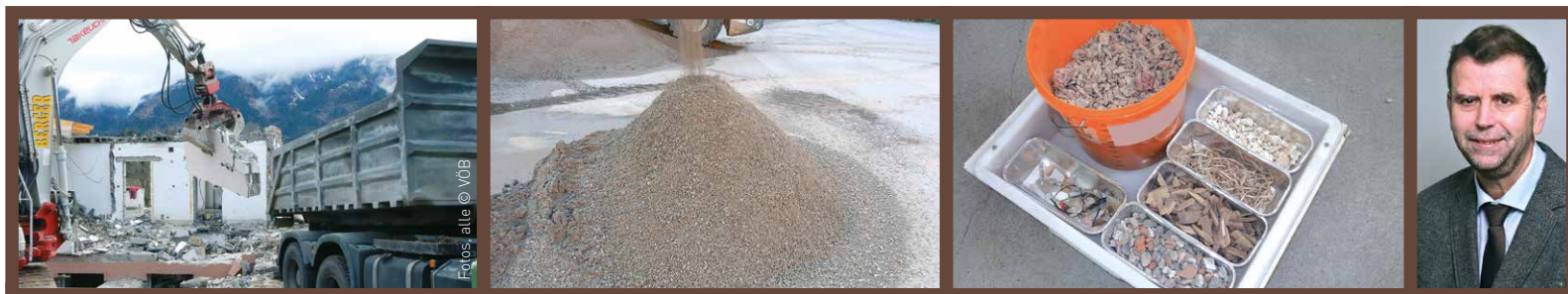
Foto 1: Holzbetonhaus beim Abbruch | Foto 2: Trennung von Holzspänen | Foto 3: Materialien nach der Trennung | Foto 4: „Holzbeton und Kernbeton werden jedoch bislang kaum getrennt. Durch die Trennung können die Bestandteile deutlich besser als bisher verwertet werden.“ Gernot Brandweiner, VÖB
