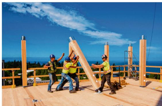
liegen beim Doppelten“, so Dünser. Da die einzelnen Holzbauteile trotz ihrer Länge von bis zu zwölf Metern in einem Teil zur Baustelle – „oder besser Montageplatz“ – geliefert werden, kann enorm schnell gebaut werden. Ein weiteres Vorteil ist dabei die Fertigungstiefe: jeder Kabelkanal, jede Steckdose, jede Auslassung kann vorab exakt erledigt werden. So wird das Studentenheim schon vier Monate vor der eigentlichen Übergabe fertig sein. Die 18 Stockwerke waren in nur neun Wochen errichtet.
