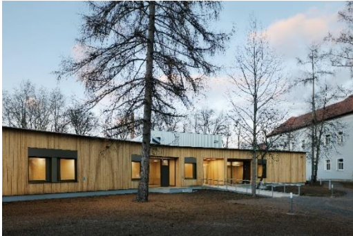
Pressefoto 5: Der Pionier-Pavillon aus Holz auf dem Gelände des LKH Graz Süd-West Standort Süd ©Paul Ott
