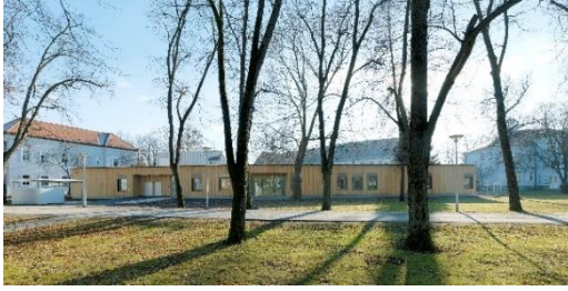
Pressefoto 4: Der Pionier-Pavillon aus Holz auf dem Gelände des LKH Graz Süd-West Standort Süd ©Paul Ott
