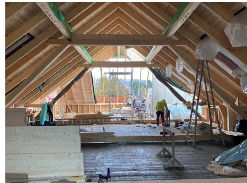
LIEGENDER STUHL NEU DG: ABLEITUNG DER LASTEN AUF DIE AUSSENWÄNDE_11/25
