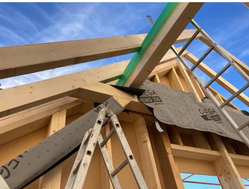
LIEGENDER STUHL NEU DG: ABLEITUNG DER LASTEN AUF DIE AUSSENWÄNDE_11/25
