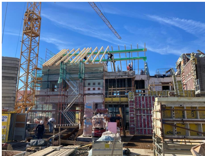
LIEGENDER STUHL NEU DG: ABLEITUNG DER LASTEN AUF DIE AUSSENWÄNDE_11/25
