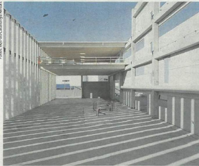
Wie eine römische Säulenhalle mutet die Zentrale des Wasserversorgers APSA an. „Zusammengehalten“ wird der großzügige Bau mit gigantischen T-Trägern von KLH aus Katsch.
